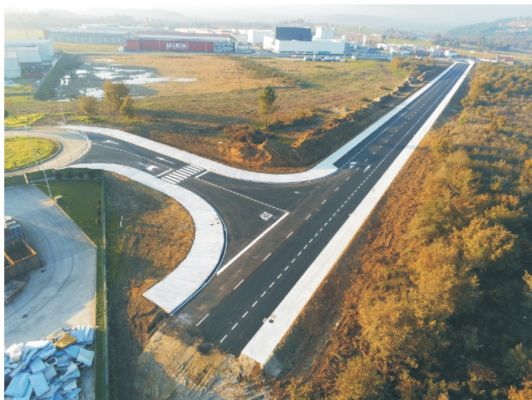
Nova vía do Polígono Industrial de O Reboredo, ubicada na súa zona norte
